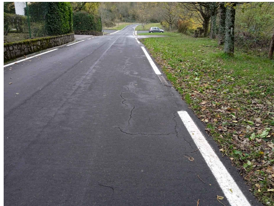
GRIETAS EXISTENTES EN ASFALTO
