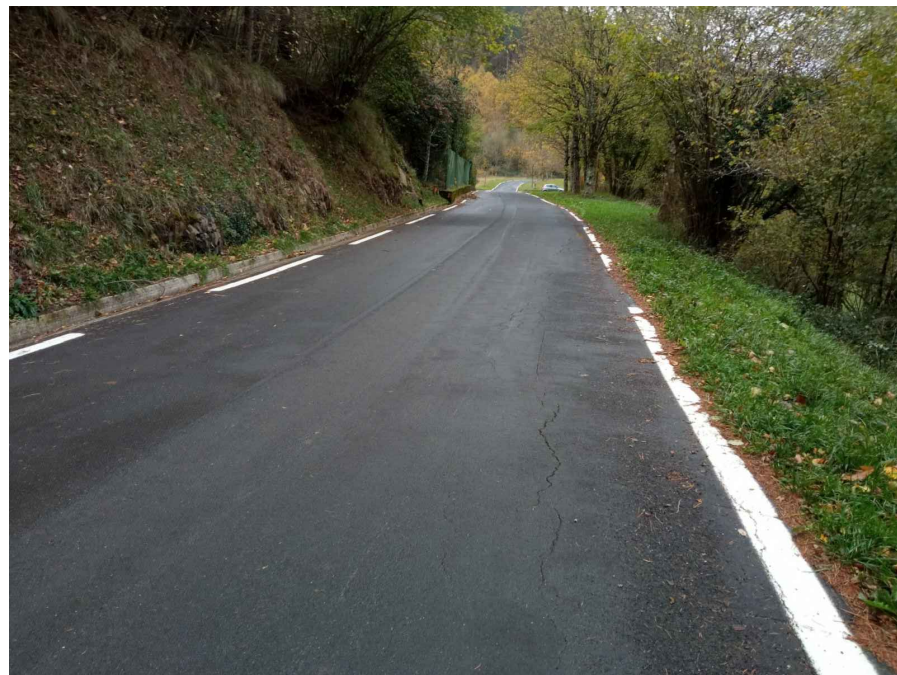
GRIETAS EXISTENTES EN ASFALTO
